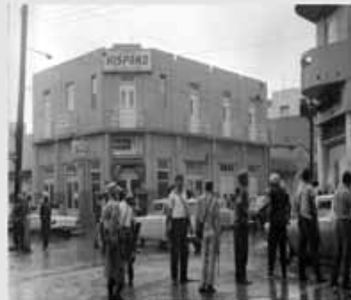
Calle Palm-Hincado con Arzobispo Nivel
