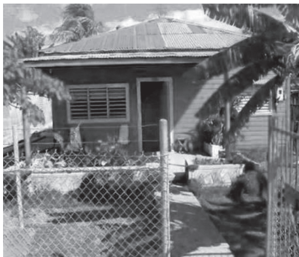
Casa del ex comandante Saborit, la cual se utilizó como cuartel general de la operación naval y en ella radicó, además, una planta de radio con la que mantenían comunicación con integrantes del MLD.
